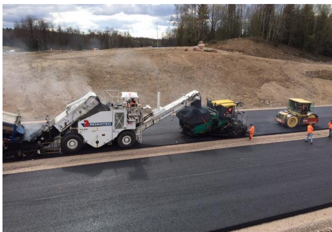
Figur 4. Bild från utförandet av bindlagret i körfält 2 som visar shuttle buggy, läggare och vält
